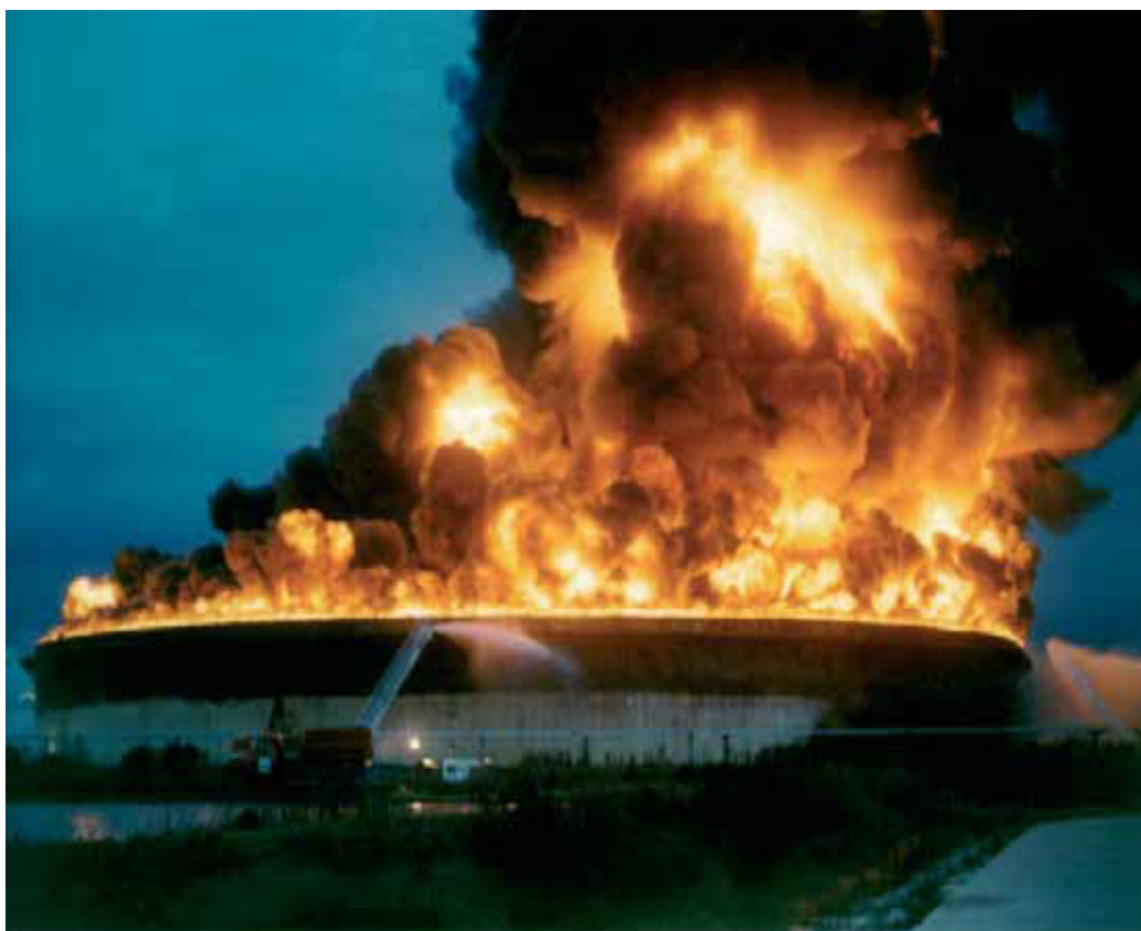
Imagen 4.9.3.2. Incendio de un tanque de combustible líquido.
