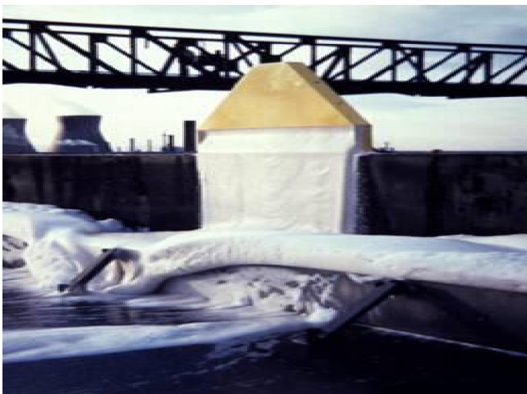
Imagen 4.9.3.1. Equipo de foam descargando sobre la superficie de un combustible
