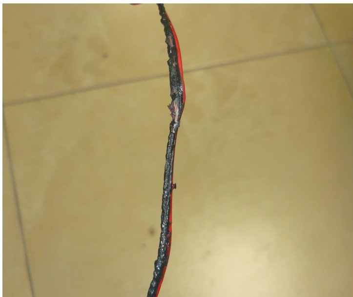
Imagen 8.3.7. Se muestra una zona del cable 24 AWG que perdió todo su aislante; en caso de encontrarse cerca de otro conductor; el incendio se hubiese vuelto termoconductorivo y por corto circuito.
