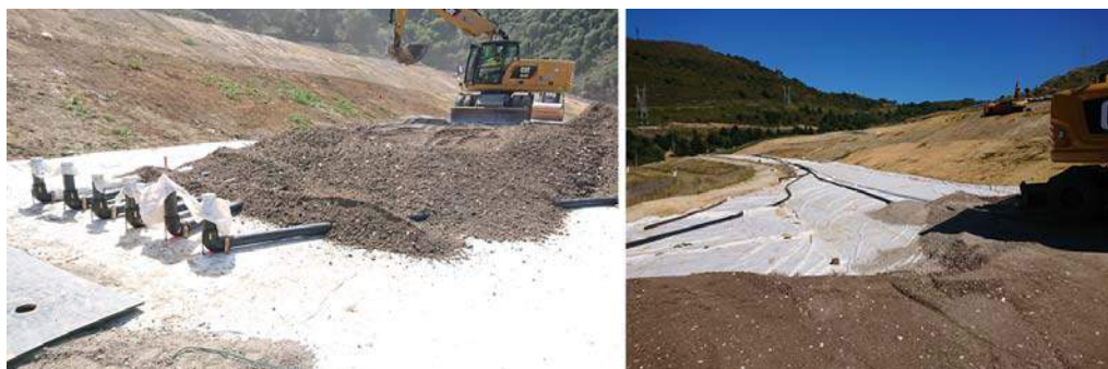
Figura 2. Empleo de árido reciclado en la capa drenante bajo la capa de sellado
