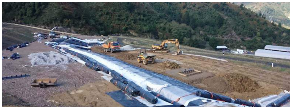
Figura 3. Vista general de las obras de sellado de la vaguada izquierda de Artigas (primera fase)
