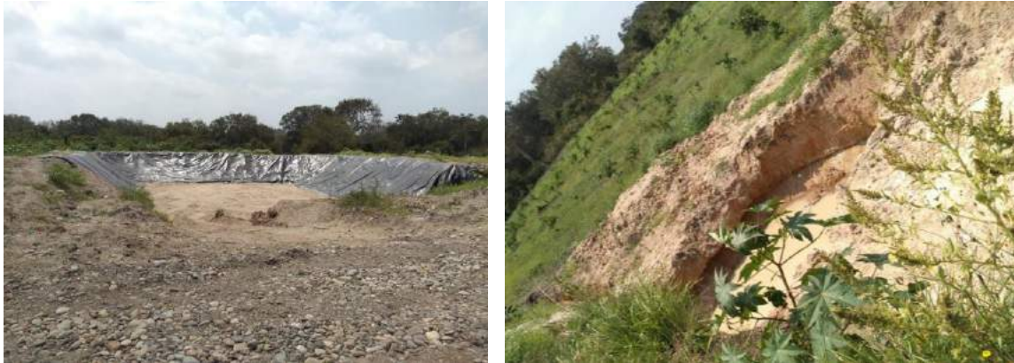
Figura 3. Primera celda y almacén de lixiviados del RS del municipio de Tecolutla, Veracruz.
