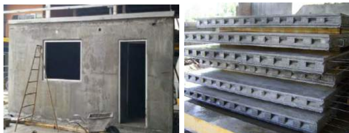
Figura 3. Paneles constructivos de mortero alivianado
