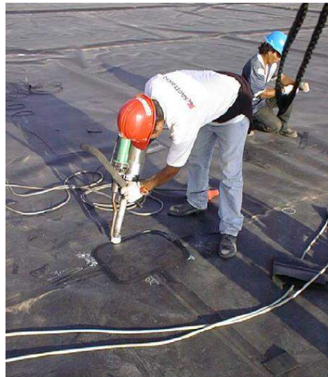
Figura 3. Unión por extrusión.
